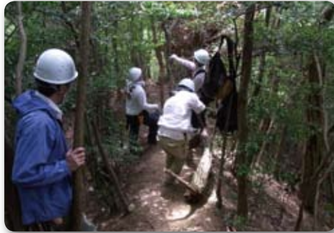
ボランティアによるハイキング道点検と整備
