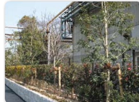
壁を取り払い沿道緑化した後の景観
