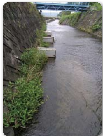
設置してから6ヶ月が経過、なんとか草が生えてきた
