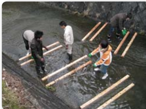
木材を使って凸凹をつける工事を実施中
